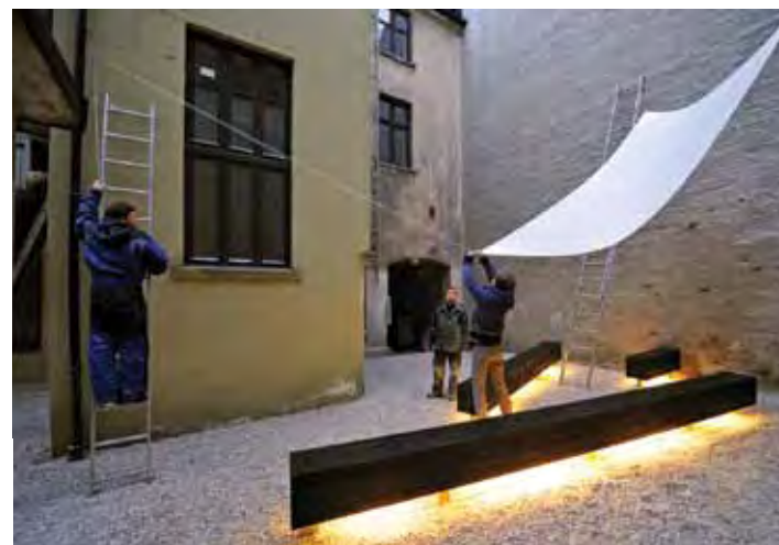
Lys, grov sand dekker asfalten. Det jobbes med montering av benkene som skal ha underbelysning. Seil blir festet med snorer horisontalt høyt over benkene, for å spre himmellyset og for å skjerme mot regn.
